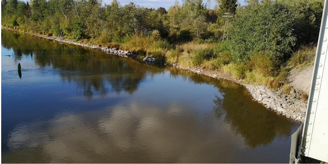
Foto 1. Vaade Vorbuse raudteesillalt ülesvoolu jõe vasakule kaldale. Sillast ülesvoolu on kallas kividega kindlustatud ca 300 m ulatuses (27.09.2019).
