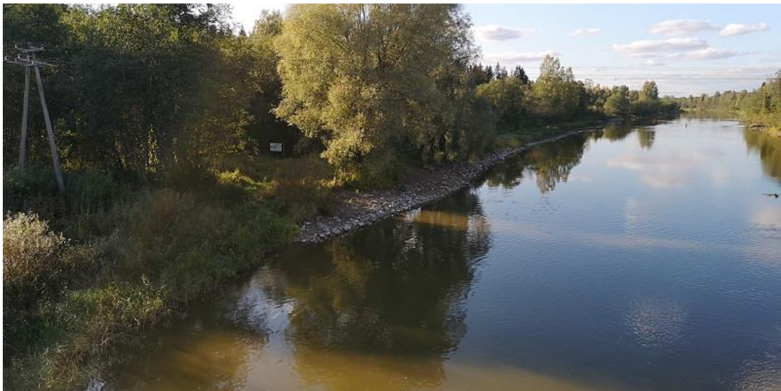
Foto 2. Vaade Vorbuse raudteesillalt ülesvoolu jõe paremale kaldale. Sillast ülesvoolu on kallas kividega kindlustatud ca 200 m ulatuses (27.09.2019).
