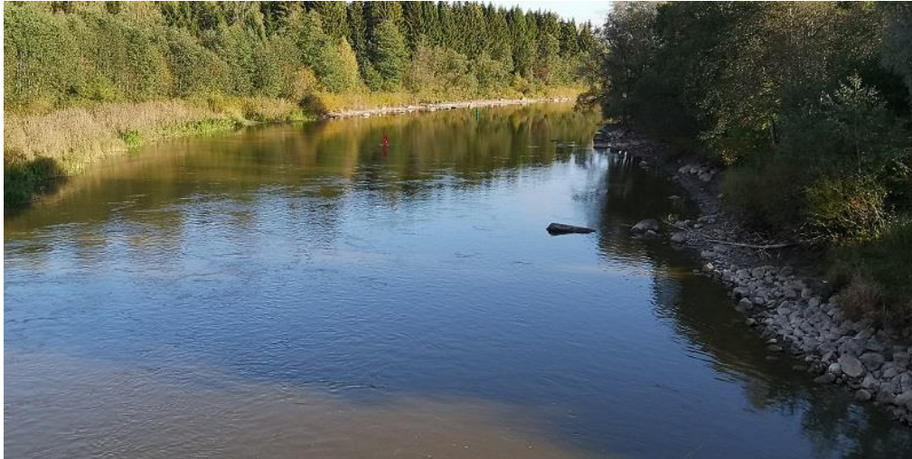
Foto 3. Vaade Vorbuse rdt sillalt allavoolu. Jõe vasakul kaldal algab kivikindlustus ca 150 m sillast allavoolu, paremal kallas on aga kindlustatud kuni 150 m sillast allavoolu (27.09.2019).
