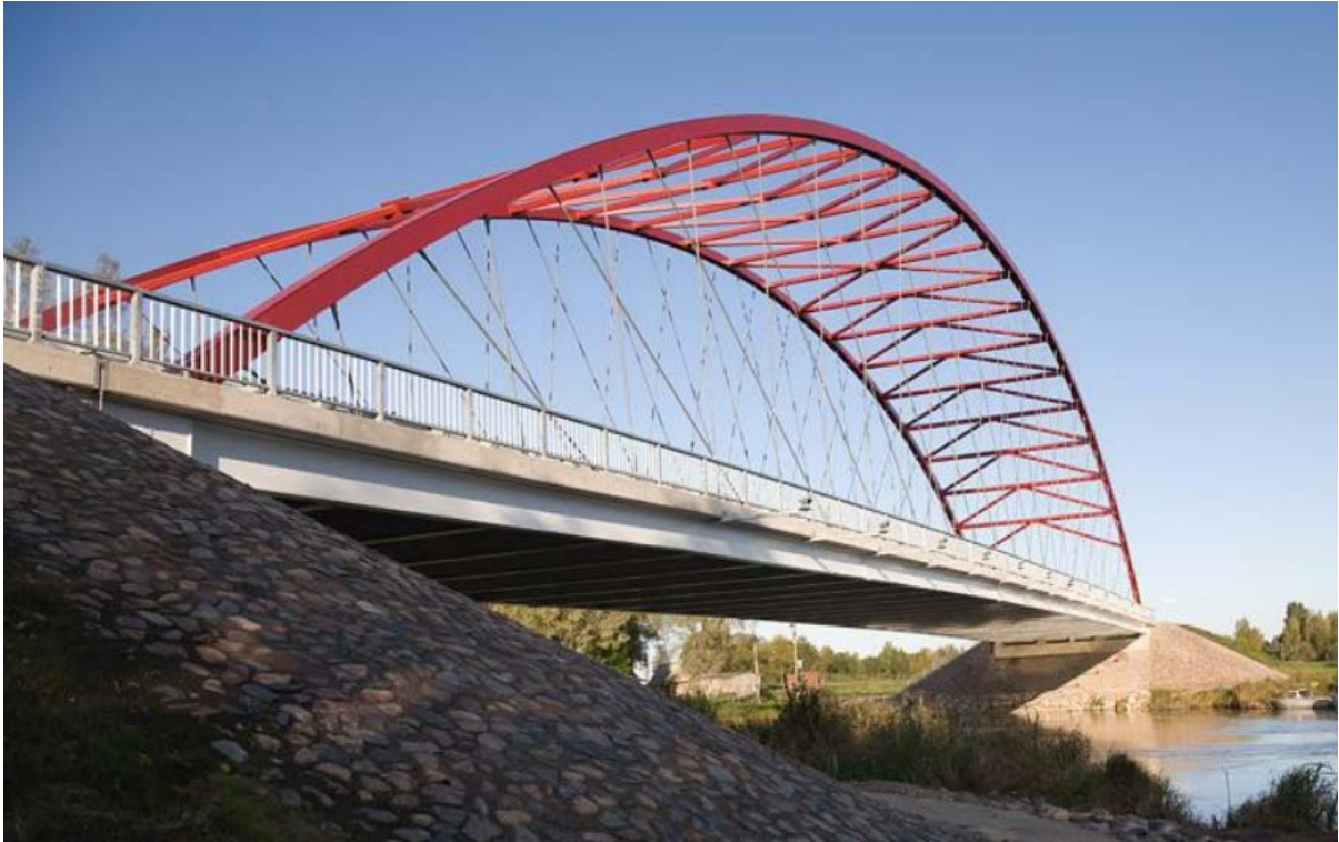
Joonis 4: Kaarsild „võrk“ konfiguratsiooniga rippurid, kaar seotud tekiga. (Rannu-Jõesuu, 90m sild, AS Merko Ehitus)
